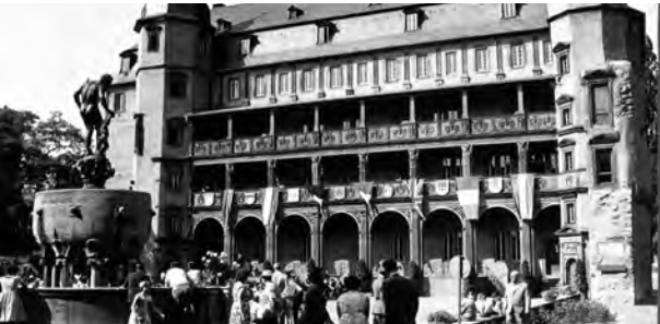
Das renovierte Isenburger Schloss, 1959 The renovated Isenburg Castle, 1959
