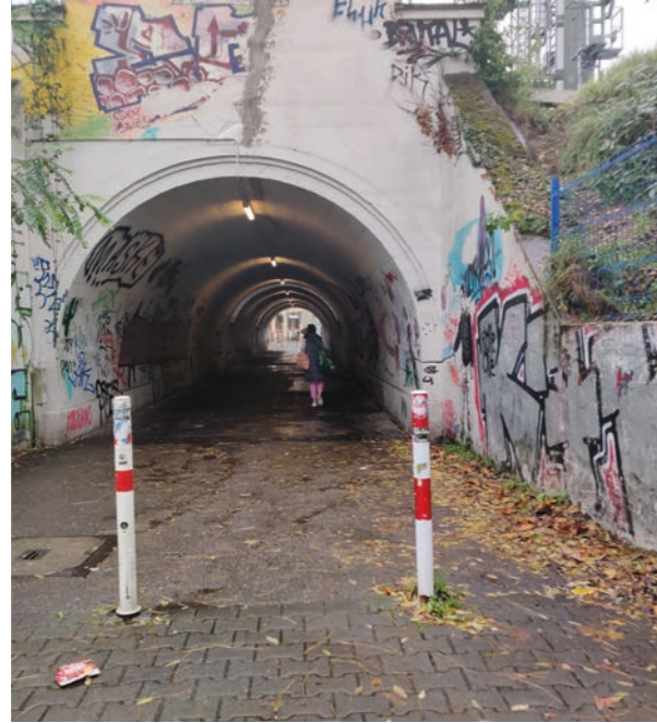
Blick in den Fußgängertunnel - Senefelderstraße View into the pedestrian tunnel - Senefelderstraße
