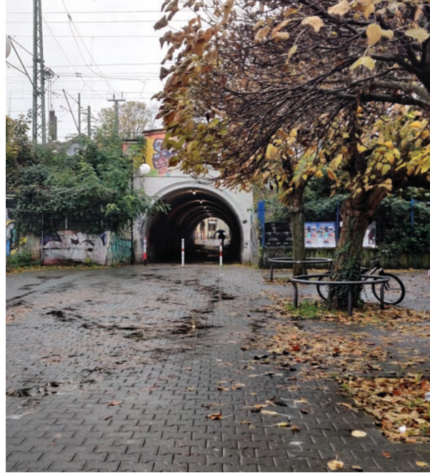
Blick in den Fußgängertunnel - Bismarckstraße View into the pedestrian tunnel - Bismarckstraße
