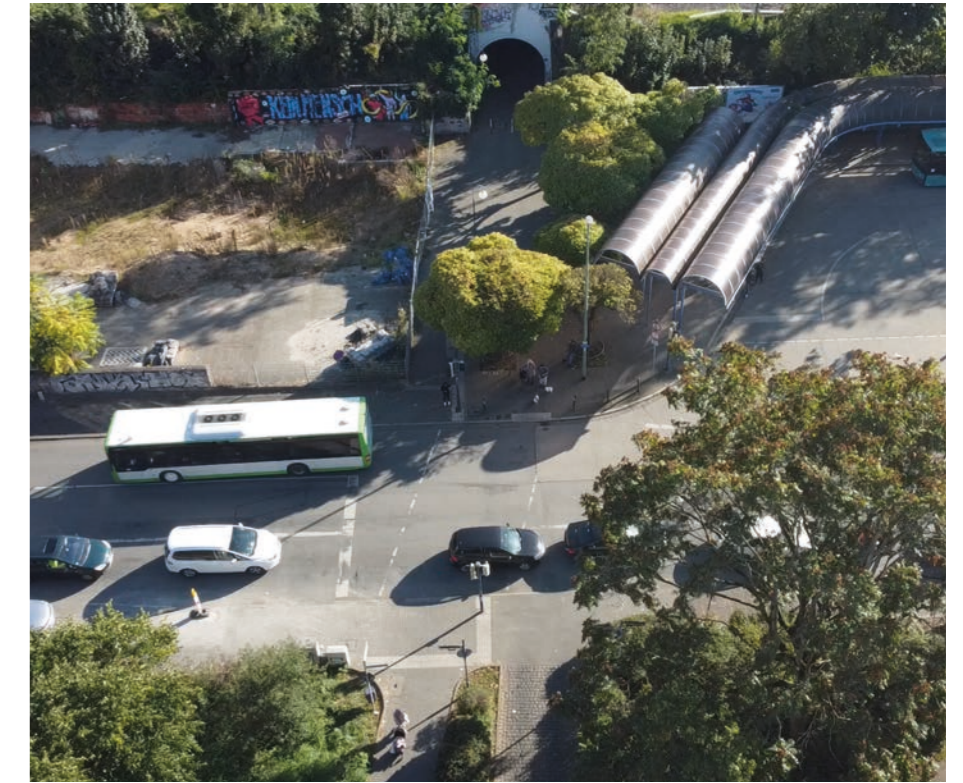
Blick auf den Busbahnhof & den Fußgängertunnel View of the bus station & the pedestrian tunnel
