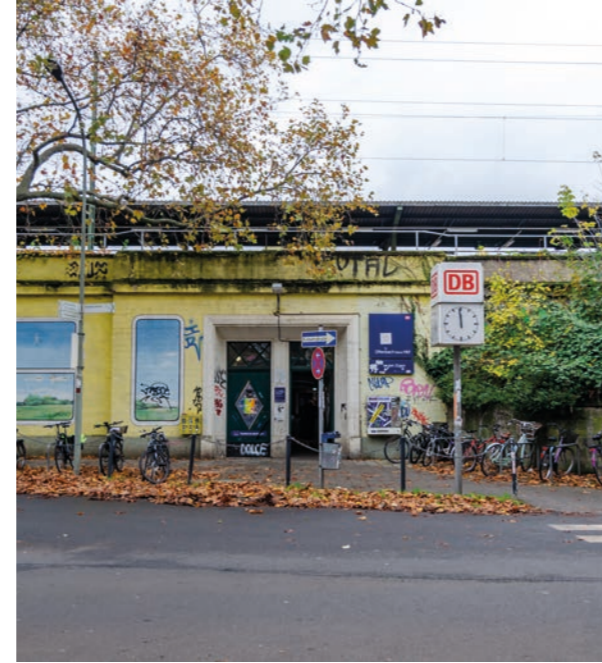
Hintereingang Rear entrance
