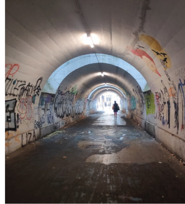
Im Tunnel Inside the tunnel
